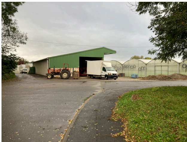
Bâtiments construits sur la canalisation (photo JP Lafond - 5/10/2012)
